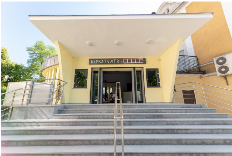
Przebudowane wejście wraz ze schodami zewnętrznymi
