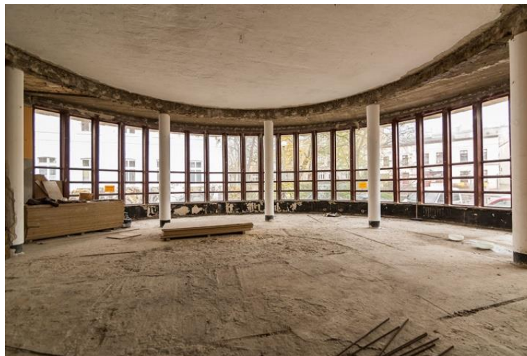
Roboty rozbiórkowe w części budynku ronda - demontaż sufitu podwieszanego.
