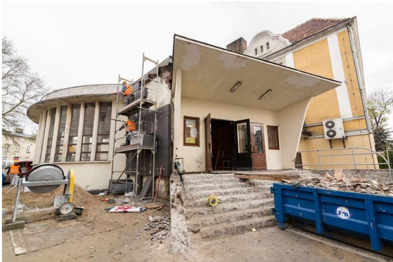
Budynek kinoteatru Rondo podczas prac renowacyjno-termomodernizacyjnych.
