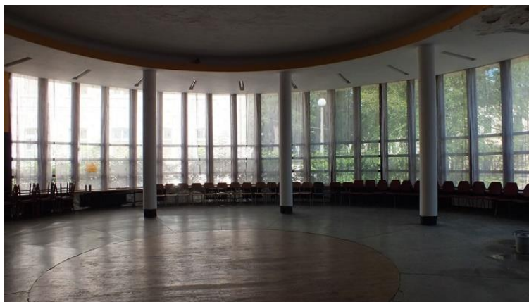
Budynek Ronda przed remontem
