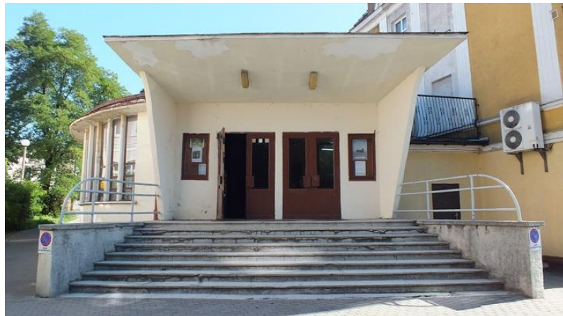
Wejście główne do kinoteatru przed remontem
