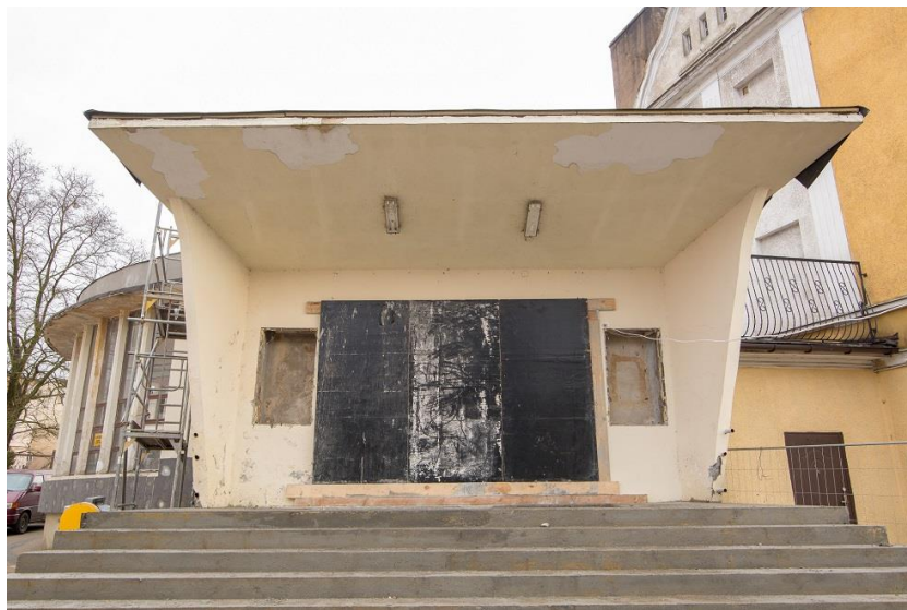
Przebudowa schodów zewnętrznych stan surowy tzn. bez okładzin na stopniach.
